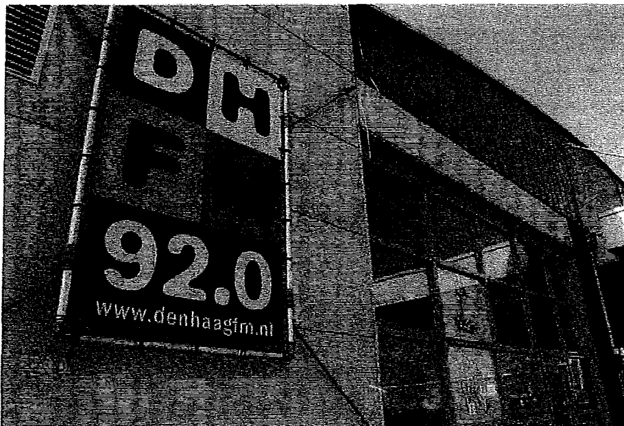
Het studlogebouw van Den Haag FM aan de Laan van 's-Gravenmade nr 4.
